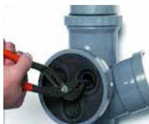
3 - En fonction du nombre et du diamètre des collecteurs sanitaires, retirer à l'aide d'une pince les **opercules du tampon de réduction universel** utiles.
