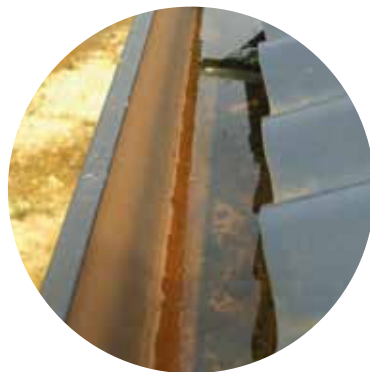
Eau stagnante dans gouttières aluminium de forme carré
